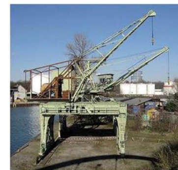
zu sanierender Portalrehrkran I
