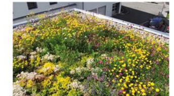
Dachbegrünung als Rückhalteelement
